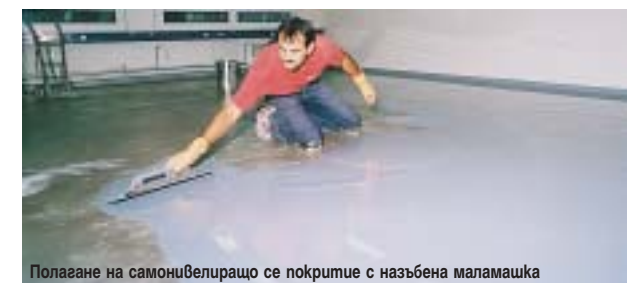
Полагане на самонивелиращо се покритие с назъбена маламашка
