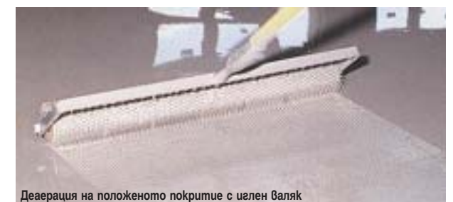
Деаерация на положеното покритие с иглен валик
